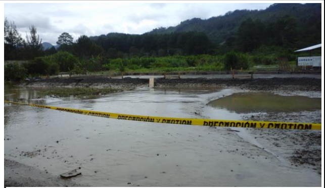
b) Sedimentación e infraestructura en la entrada a Creompaz. 2017.
