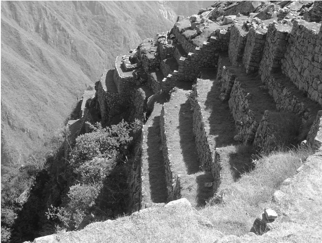
Figura 15.3. Muros de contención del siglo XV en la ciudad de Machu Picchu (Perú). Fotografía: autores.
