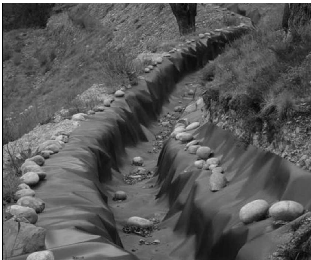
Figura 16.5. Geotextil impermeable en la base de una cuneta. Fotografía: autores.
