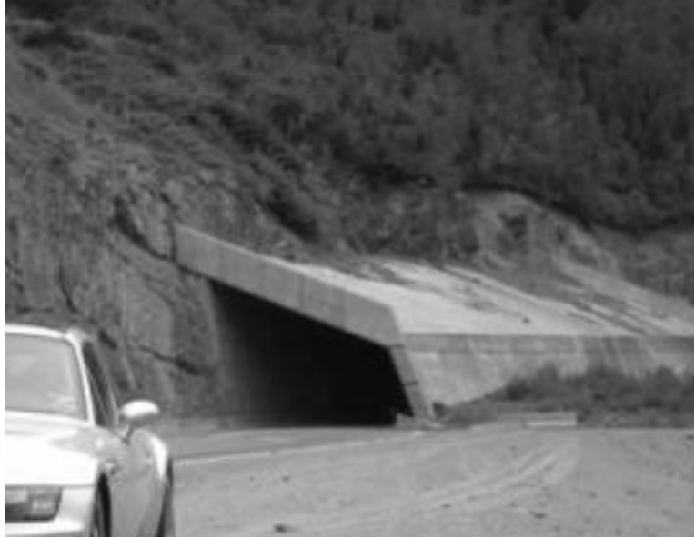
Figura 14.36. Falso techo o semi-túnel, muy adecuado para la protección frente a desprendimientos en zonas de montaña.
