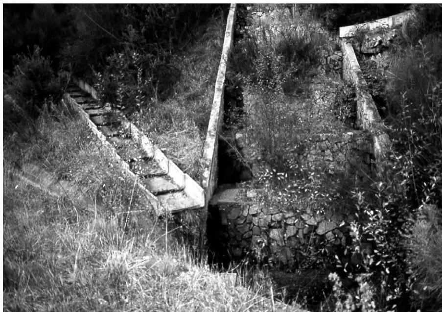
Figura 16.8. Detalle de drenes en espina de pescado. Fotografía H. Stockhausen.
