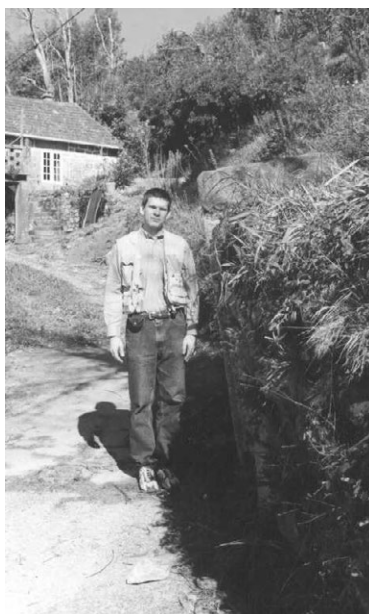
Figura 11.14 (foto): Detalle del portal inclinado en la base de la zona deslizada. Al fondo se observa la casa por donde se ubicó la base de la zona deslizada.
