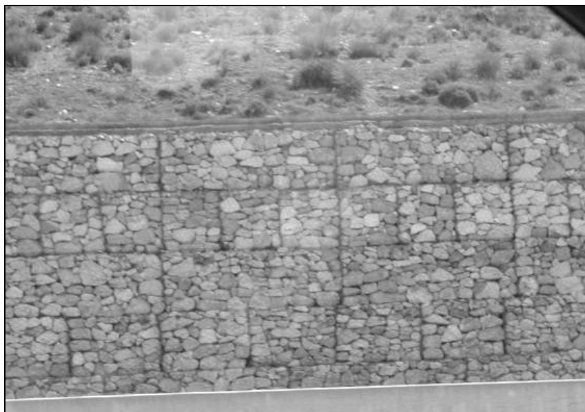
Figura 15.8. Muro de gaviones. Fotografía: autores.
