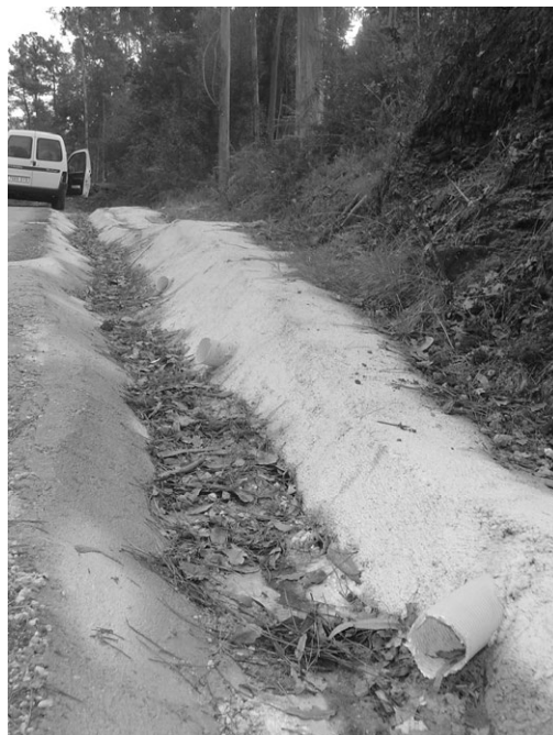
Figura 16.17. Talud con drenes californianos. Fotografía H. Stockhausen.
