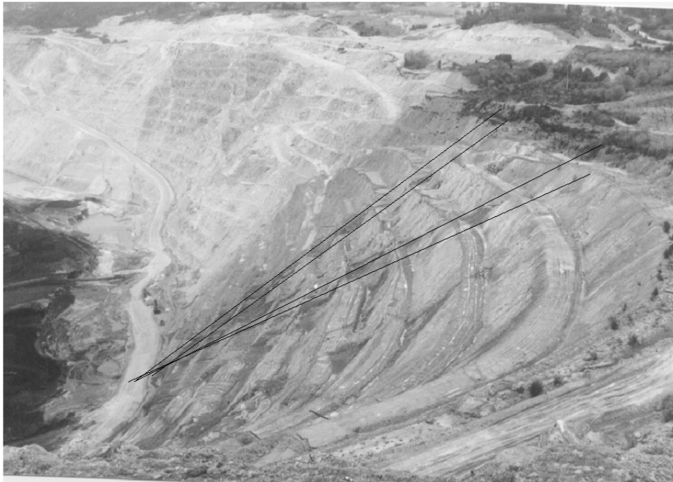
Figura 9.14 – Ejemplo de una gran cuña en equilibrio metaestable en un gran corta minera y que afecta prácticamente a todos los bancos de la explotación. Foto: autores.
