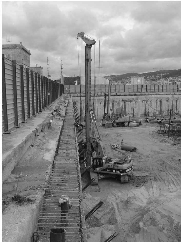
Figura 15.5. Muro de hormigón armado para la construcción de un edificio con varias plantas subterráneas. Fotografía: autores.
