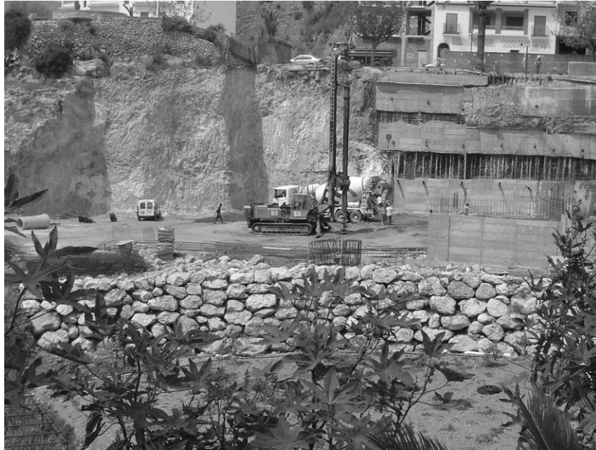
Figura 15.7. Muro de escollera para explanar una zona del terreno. Obsérvese su bajo impacto debido a su integración en el paisaje comparado con los muros de hormigón que también se muestran en la fotografía. Fotografía: autores.
