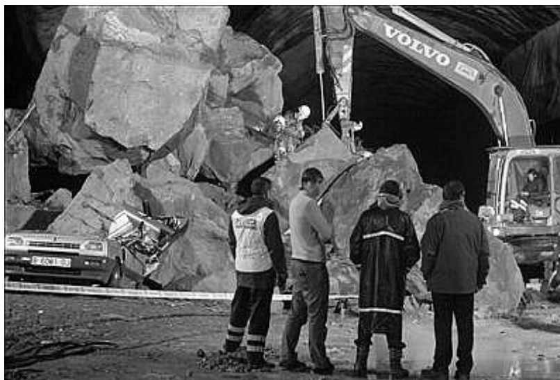
Figura 14.3. Fotografía de prensa de un desprendimiento de bloques en el portal de un túnel en la provincia de Girona, ocurrido a finales del año 2005 y que produjo una víctima. Foto: Diario el Mundo.
