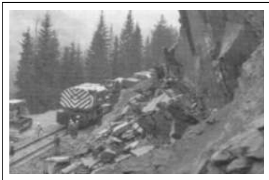
Figura 10.4.: Caída por vuelco bloques. Según Hoek & Bray (1974).
