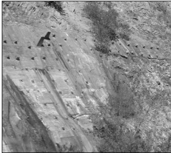
Figura 15.34. Muro de revestimiento anclado. Fotografía: autores.
