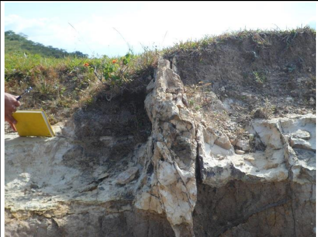
f) Falla inversa y estructura dúplex afectando depósitos superficiales (niveles de suelo orgánico)
